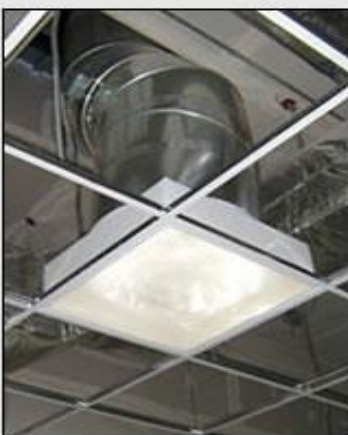
21" 530 mm met transit box in systeemplafond
